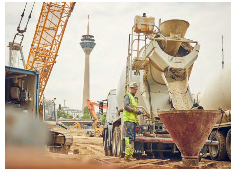
Betonage der Schlitzwandlamellen in Sichtweite zum Rheinturm
