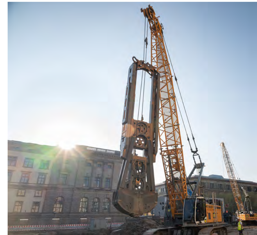
5.240 m² Schlitzwände für die Baugrubenumschließung der größeren Baugrube im Baufeld A
