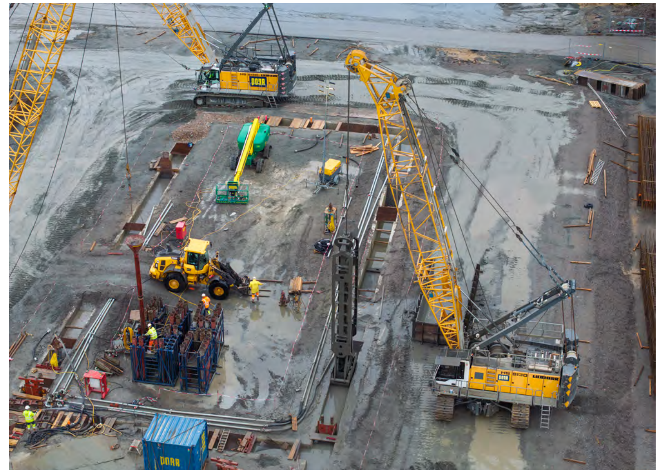
Die Schlitzwände wurden bis zu 60 m tief hergestellt.
