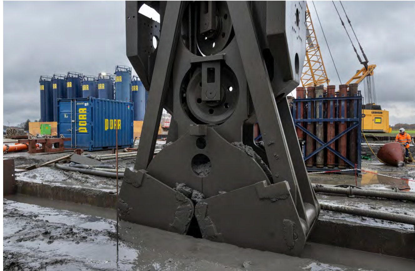
Herstellung der Schlitzwände bis 120 cm Dicke
