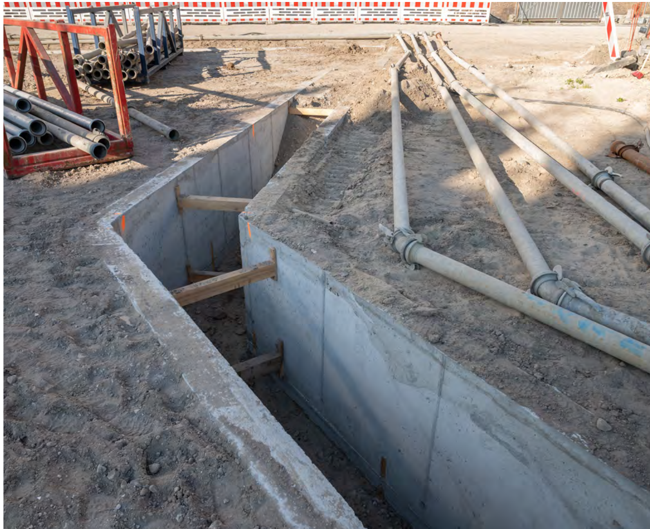
Vorab hergestellte Leitwände dienen dem Greifer als Führung.
