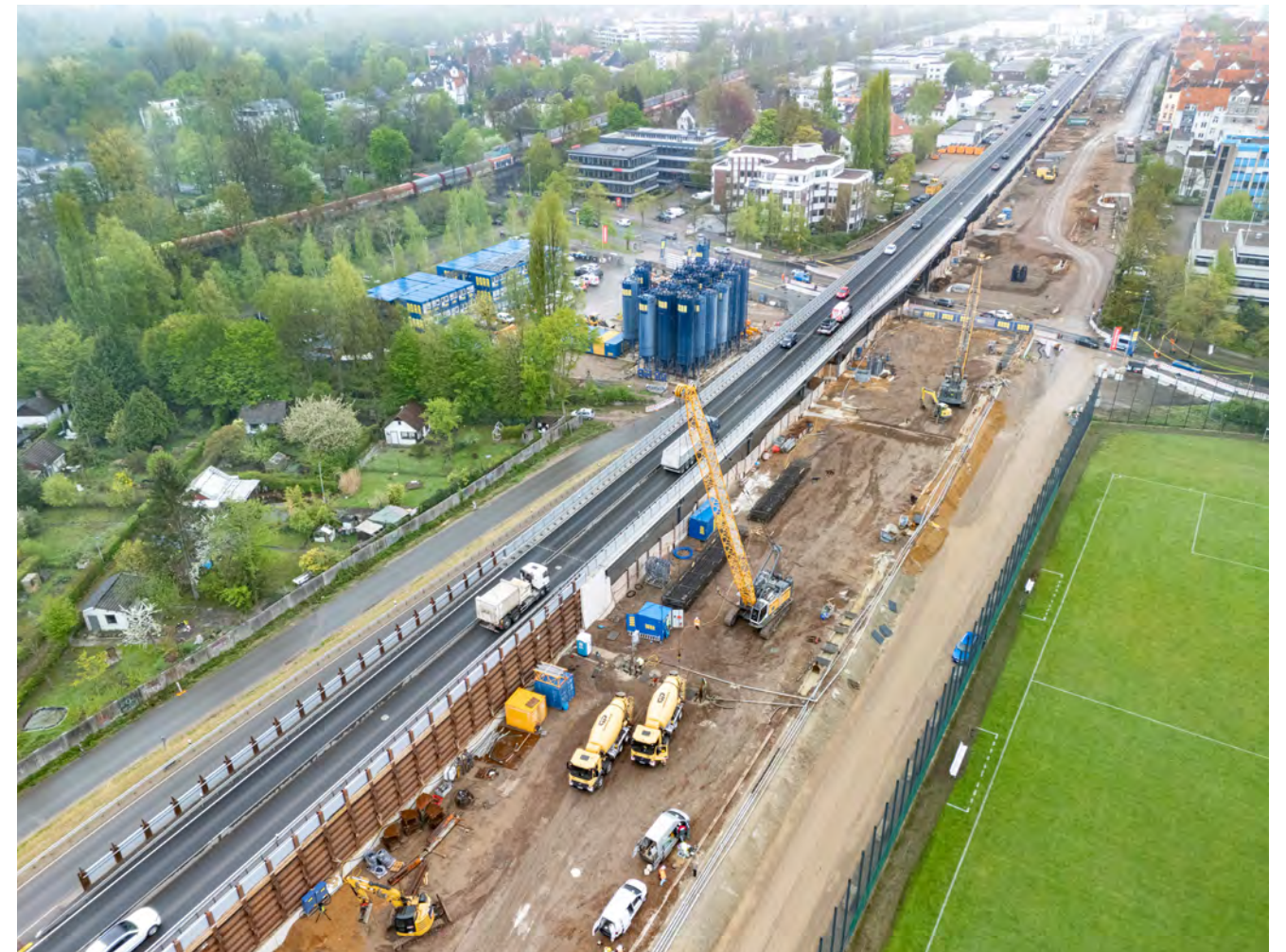
Sobald auch die zweite Baugrubenwand fertiggestellt ist, wird der Boden zwischen den Wänden abgetragen und die Ingenieurbauarbeiten für den Straßentunnel mit Rampenbauwerken beginnen.
