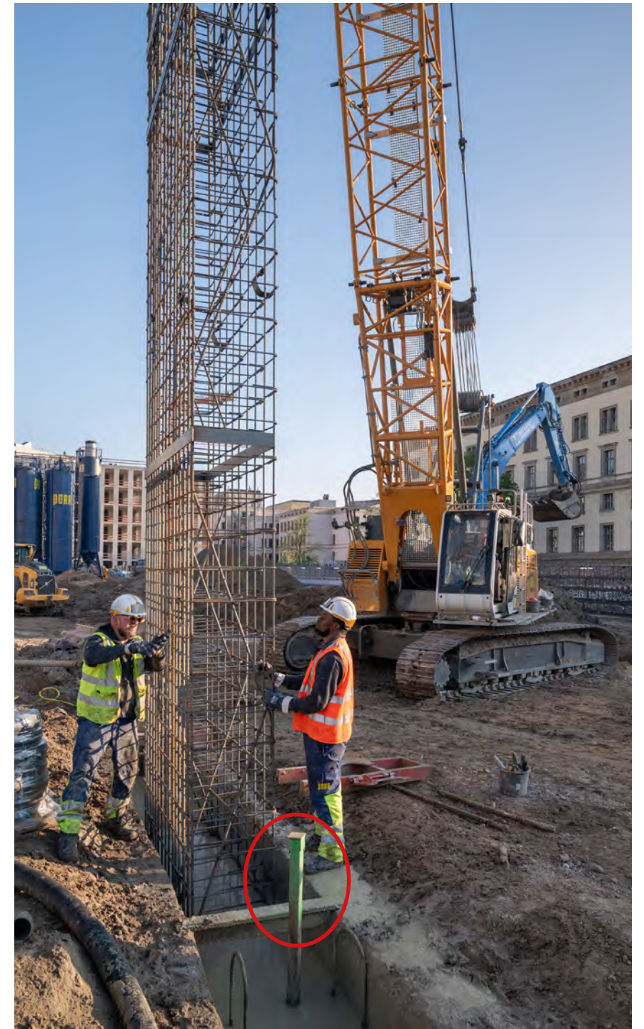
Einbau eines Bewehrungskorbes. Im Vordergrund befindet sich ein Inklinometer zur Überwachung der Vertikalität und der Verformung.
