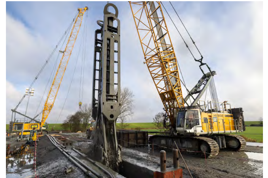
Die Schlitzwandarbeiten für die Zielbaugrube wurden im Februar 2025 erfolgreich abgeschlossen.
