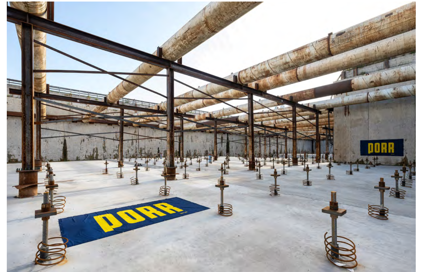
Schlitzwandbaugrube mit Innenaussteifung und Sohlen-Auftriebssicherung
