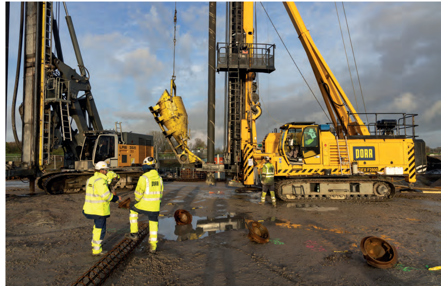
Insgesamt kamen ca. 5.650 Fundex-Pfähle mit einem Durchmesser von 44/56 cm und einer Länge von etwa 23 Metern zum Einsatz.
