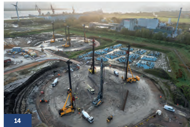
Fundexpfahl: LNG Terminal, Brunsbüttel
