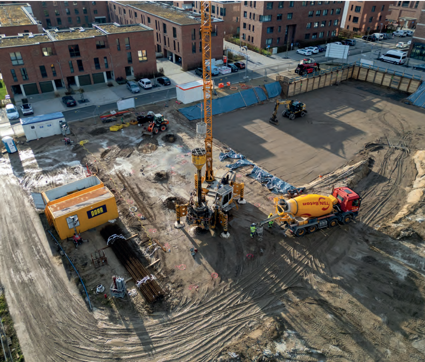
Nachhaltige Pfahlgründung mit Atlas Vollverdrängungsbohrpfähle nach DIN EN 12 699.
