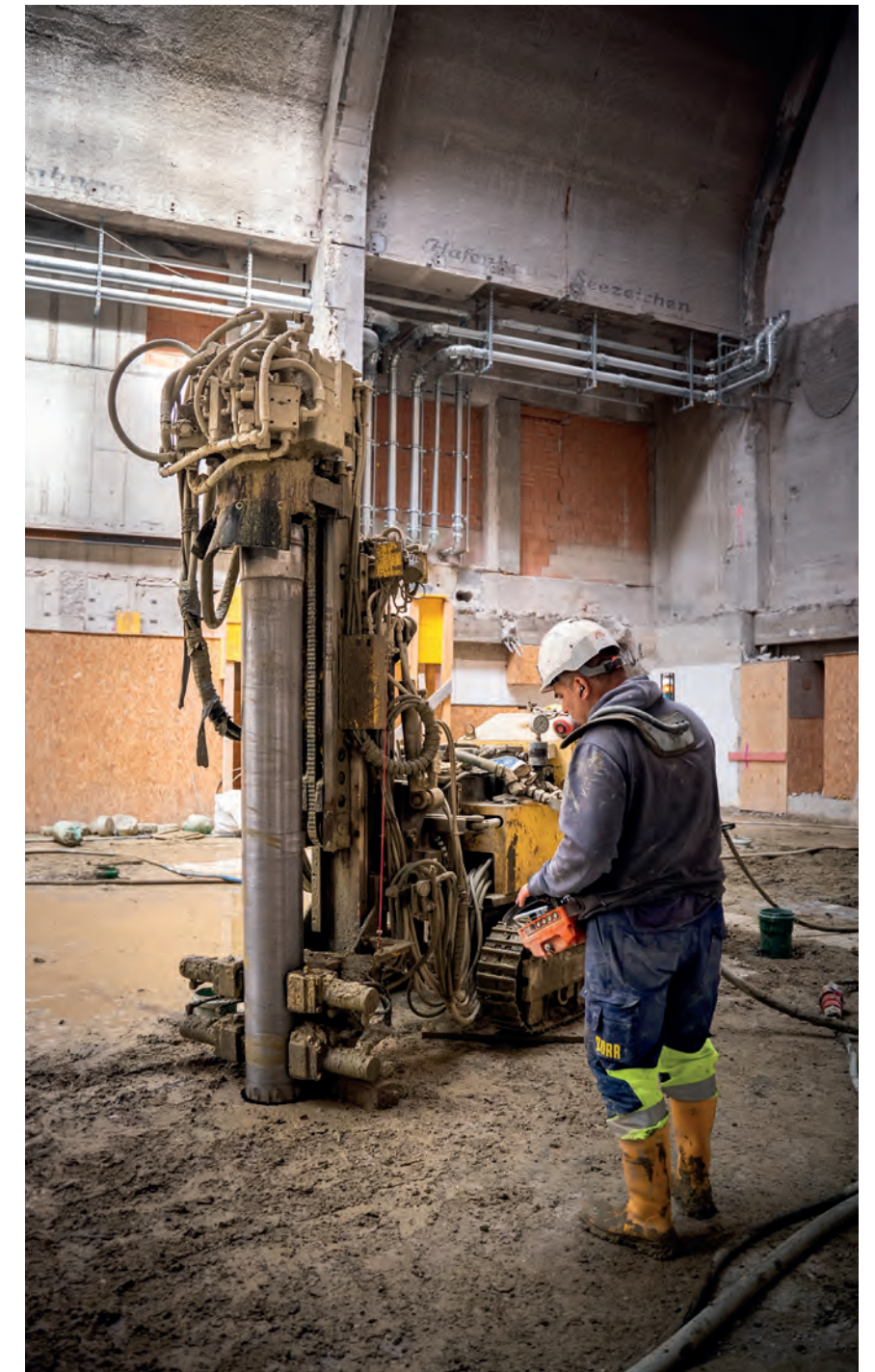
Dank modularer Stahltragglieder, die vor Ort gekoppelt wurden, war selbst bei geringer Arbeitshöhe eine sichere Gründung gewährleistet.
