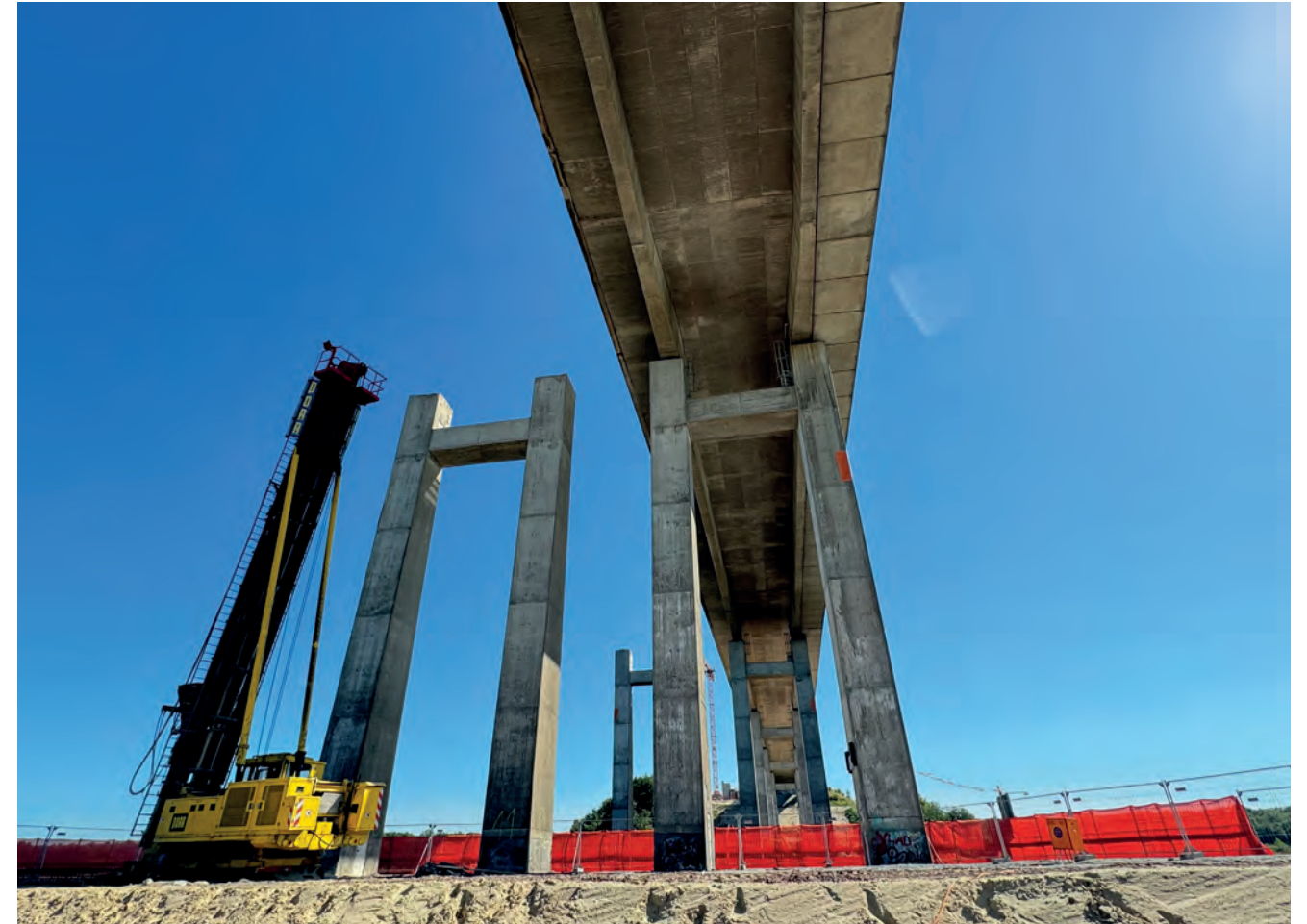
Die Rammarbeiten werden neben den Bestandspfeilern ausgeführt.
