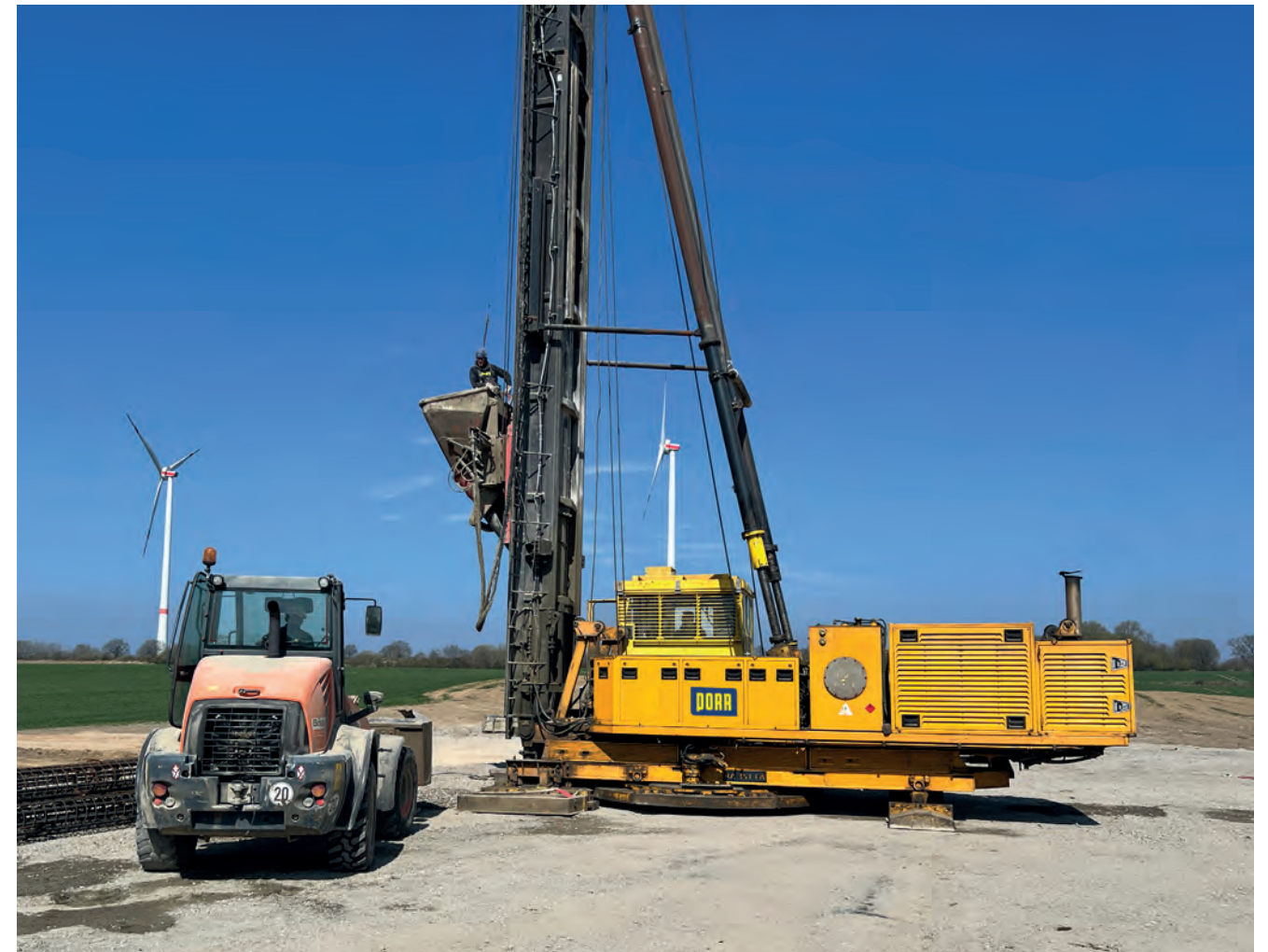
Der Gründungsarbeiten mit Frankipfählen beim Windpark Bosau wurden von der DGNB als Nachhaltige Baustelle im Spezialtiefbau zertifiziert.
