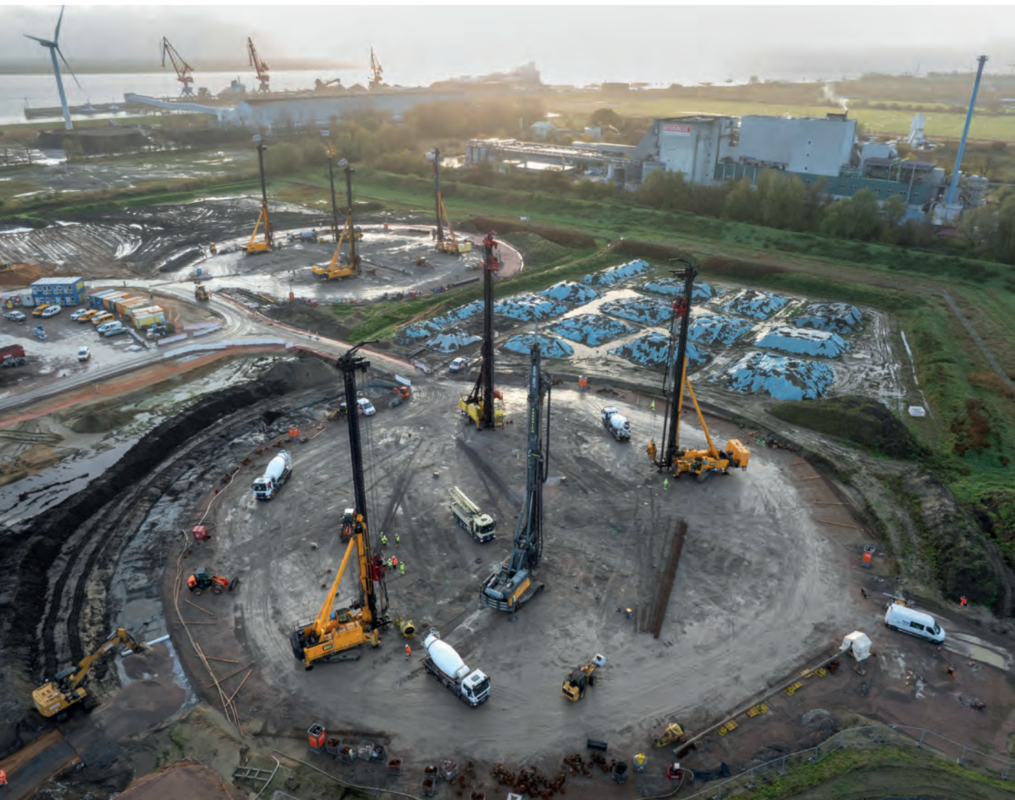
Acht große Bohrgeräte waren gleichzeitig im Einsatz. Die Herstellung der Fundexpfähle erfolgte lärmarm und erschütterungsfrei, ohne Bodenförderung.
