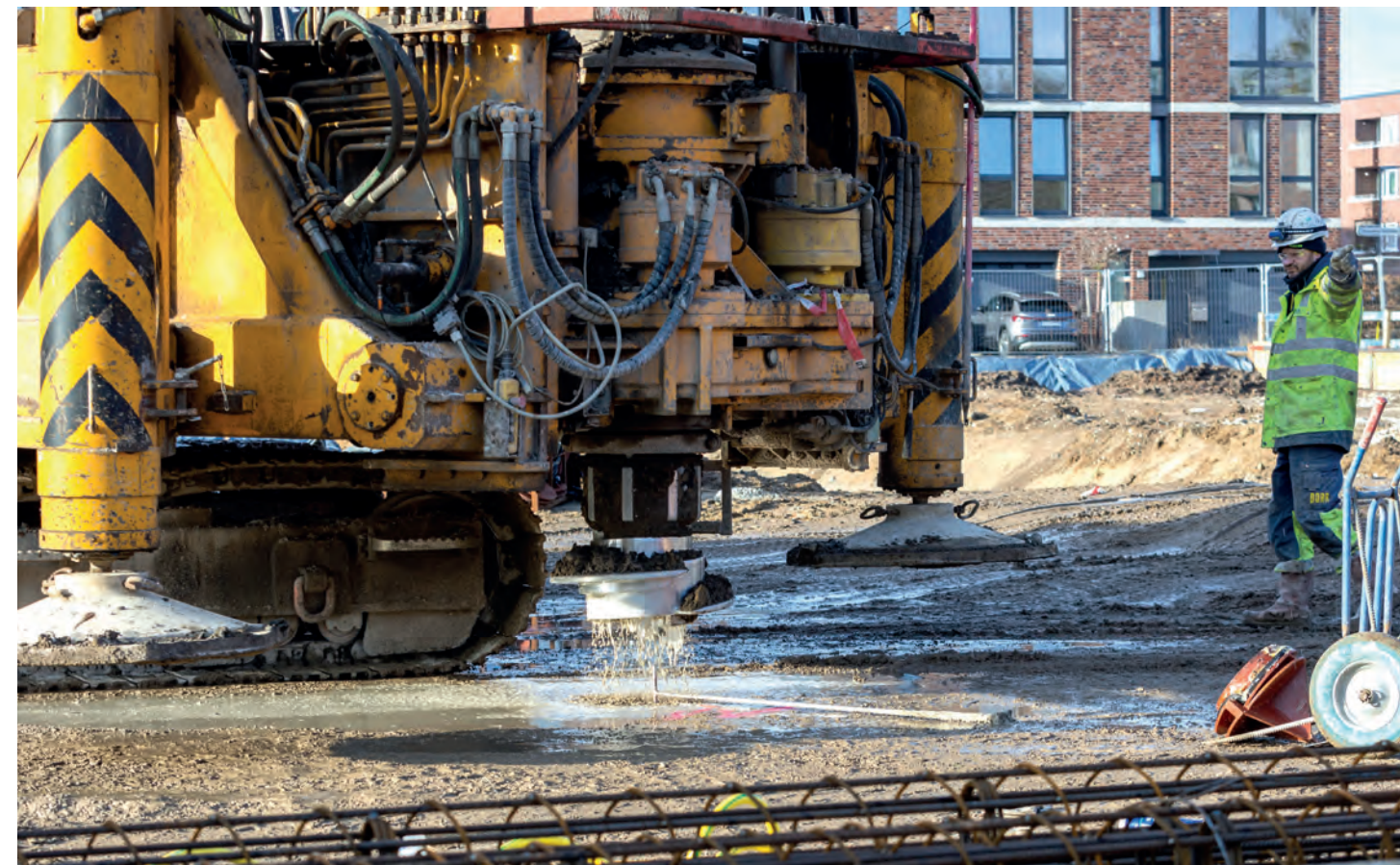
Der Atlas-Schneidkopf formt den gewindeartigen Pfahl.
