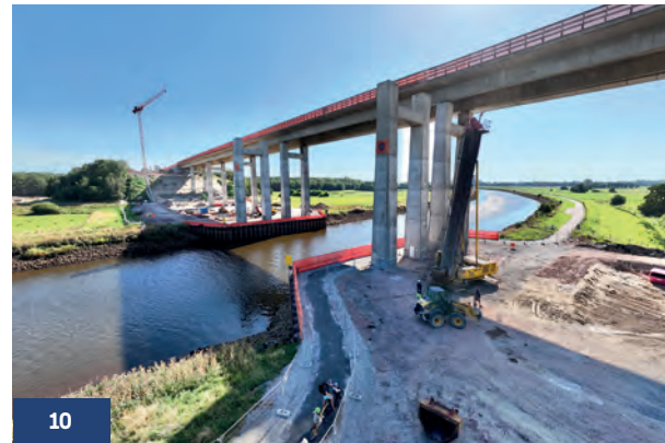
Frankipfahl NG®: Huntebrücke, Oldenburg
