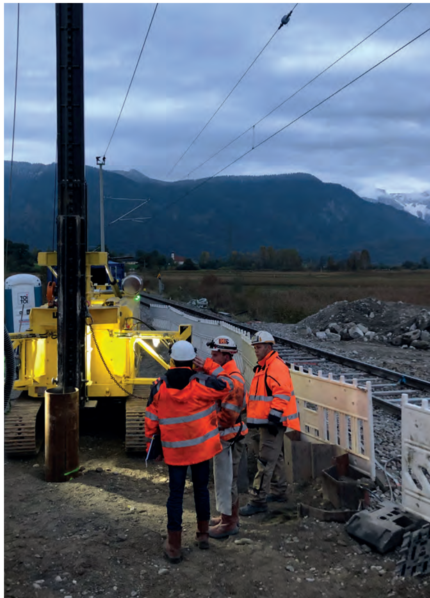
Sichere Pfahlgründung unter Eisenbahnbetrieb
