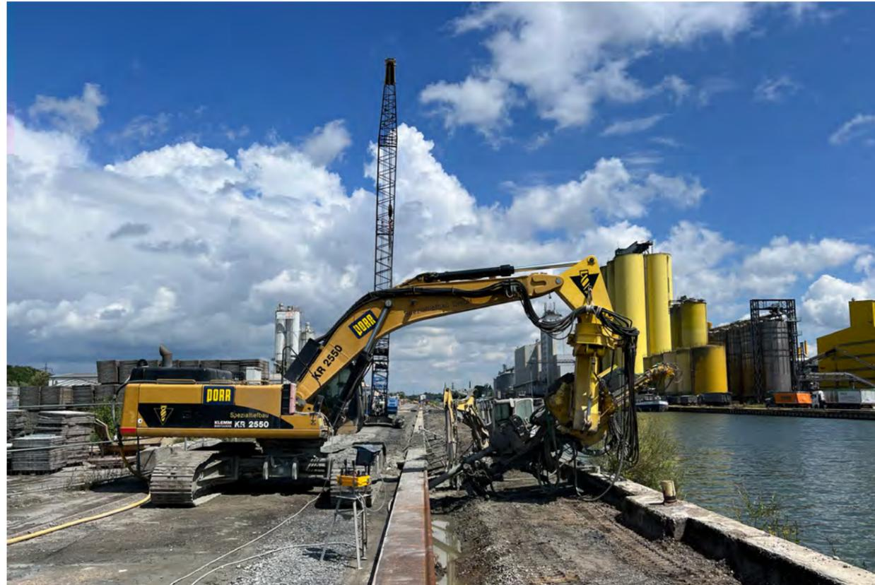
Die Ausführung erfolgte teilweise mit einem Bohrbagger unter Flur.
