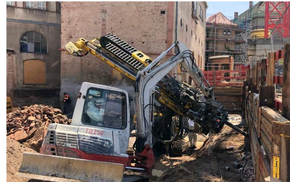
Rückverankerung der Trägerbohlwand.
