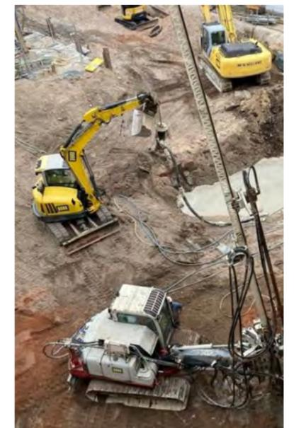
Unterfangung im Düsenstrahlverfahren.
