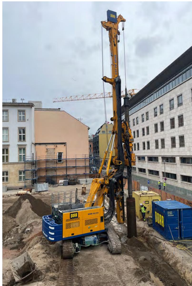
Die Spezialtiefbauarbeiten werden mit größter Sorgfalt ausgeführt und von Erschütterungs- und Setzungsmessungen engmaschig begleitet.
