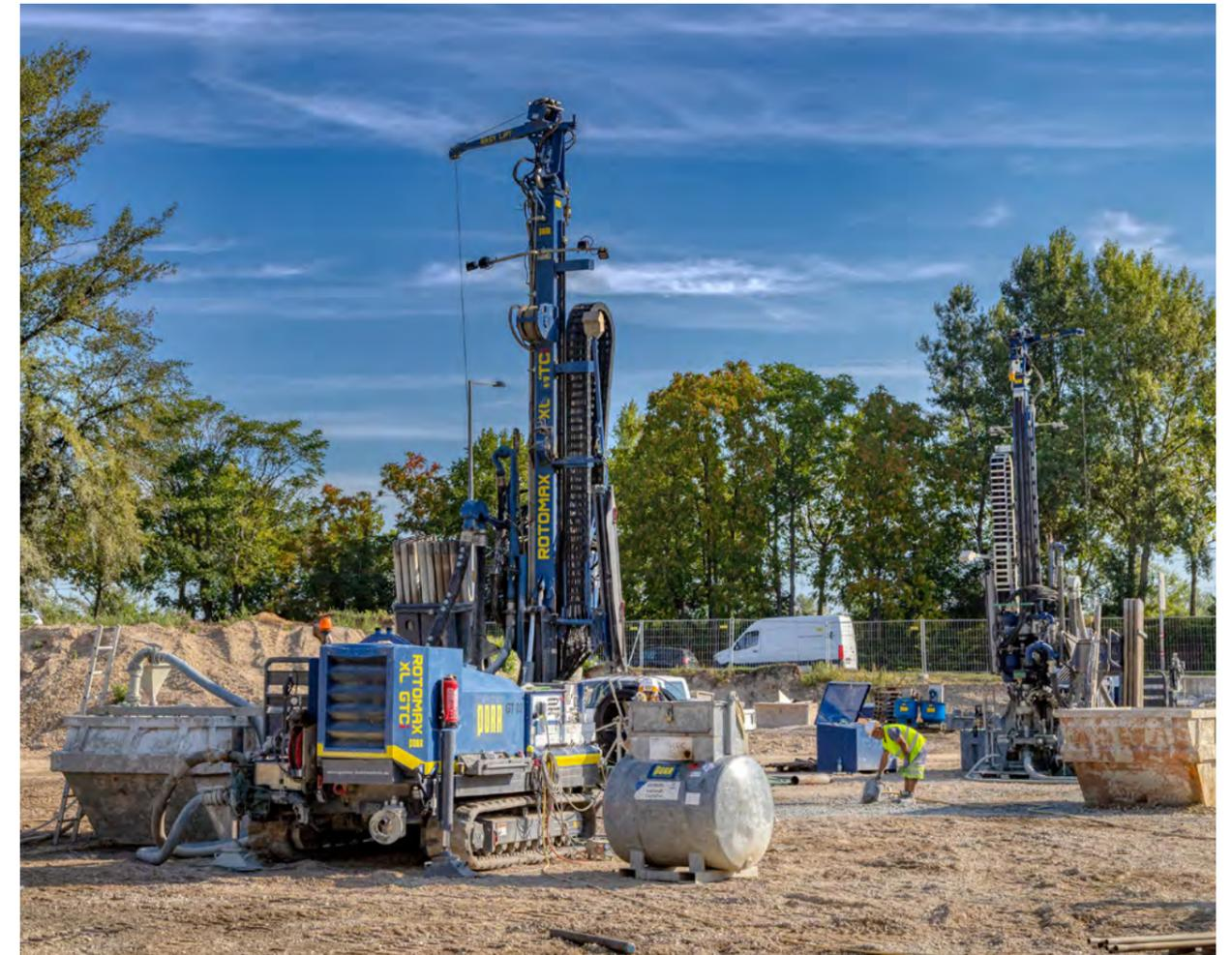
Oberflächennahe Geothermiebohrungen bis 400 m Tiefe möglich.
