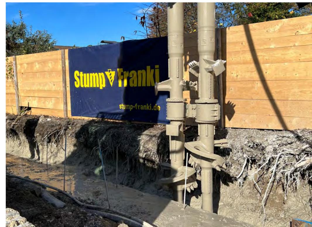
Das Bodenmischen erfolgt mit einem mäklergeführten doppelten Mischpaddel. © Stump-Franki
