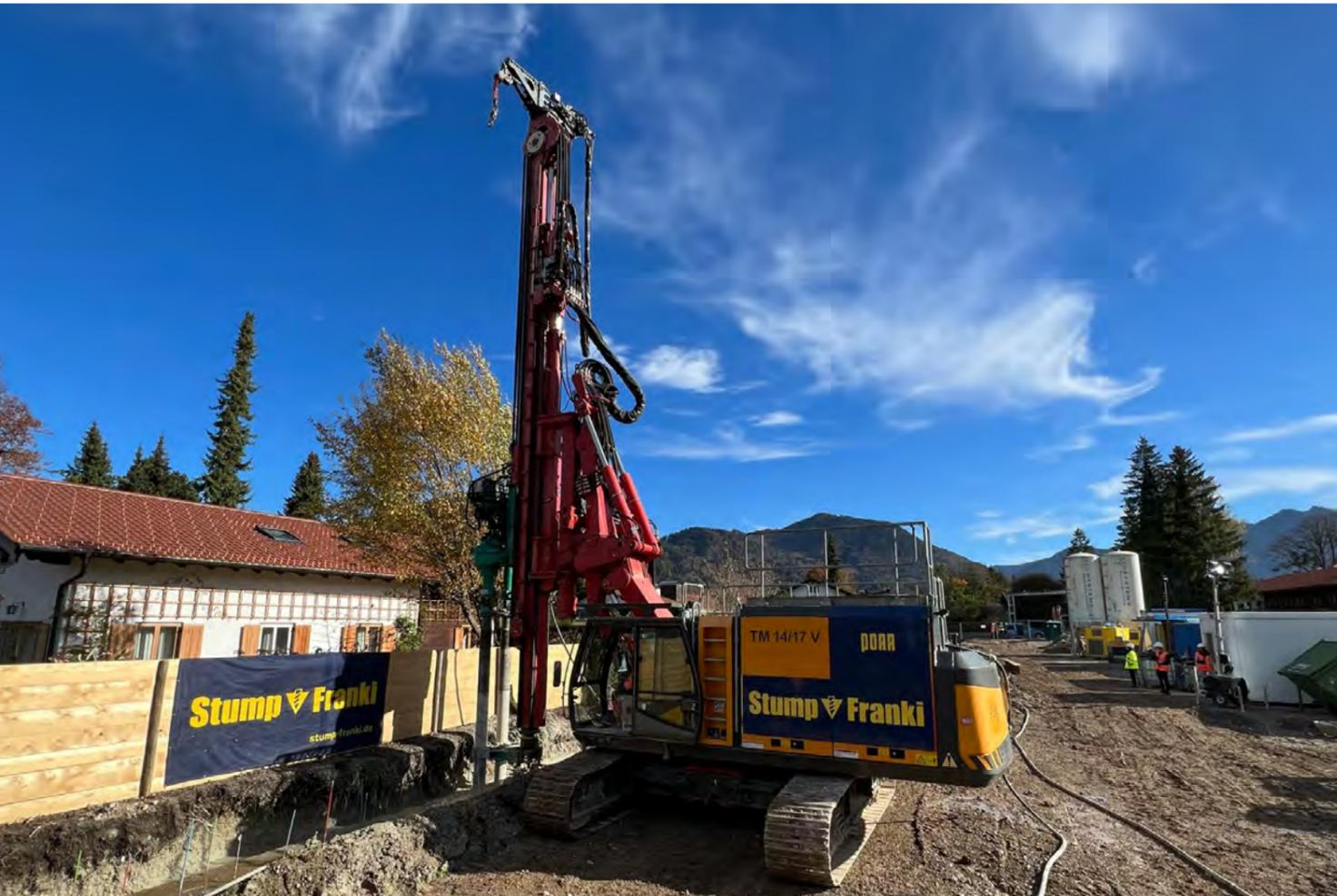
Herstellung der Baugrubenwand direkt an der Grundstücksgrenze © Stump-Franki
