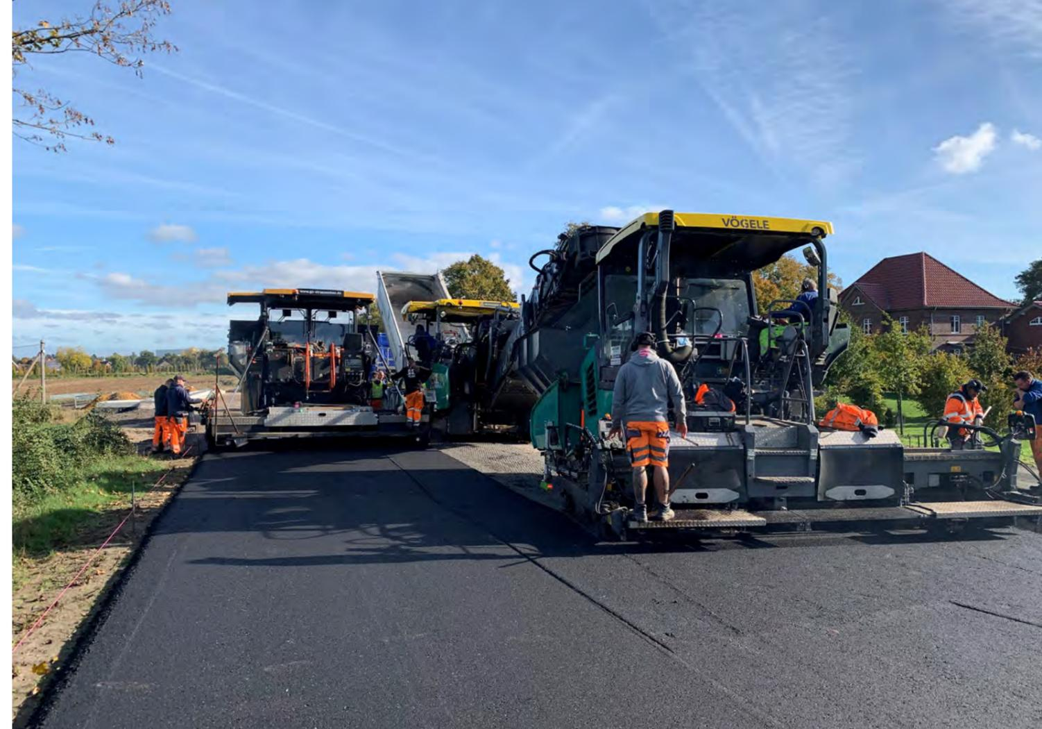
Schächte. Weitere 2.000 m der Fahrbahn wurden neu hergestellt, wobei teilweise die komplette Fahrbahn samt Untergrund erneuert und PAK-belastetes Material entsorgt werden musste. In den restlichen Bereichen wurde die vorhandene Asphaltdeckschicht profilgerecht abgefräst.
