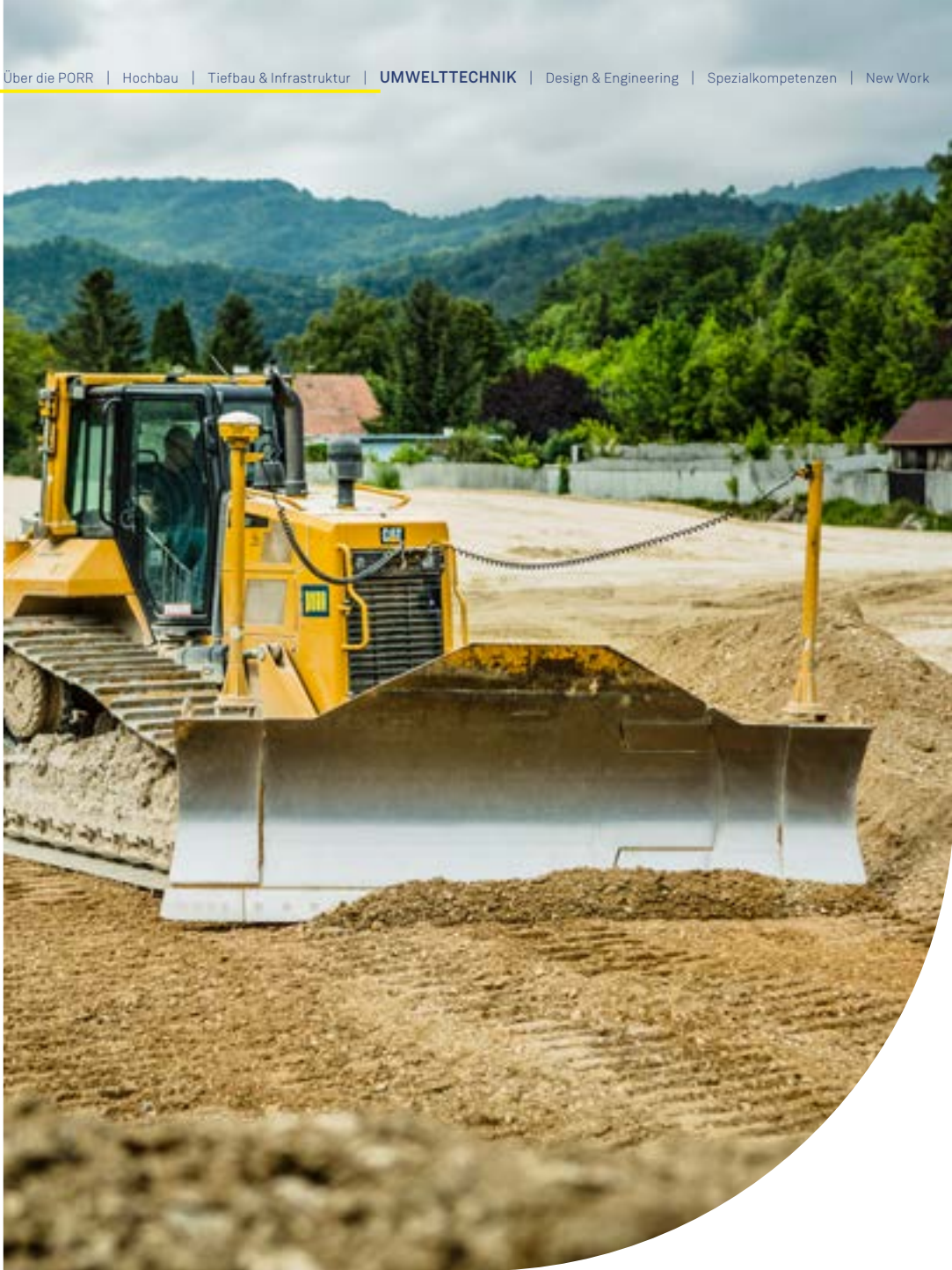
Hochwasserrückhaltebecken Fahrafeld/NÖ – Österreich Erdbauarbeiten beim größten Rückhaltebecken Niederösterreichs
