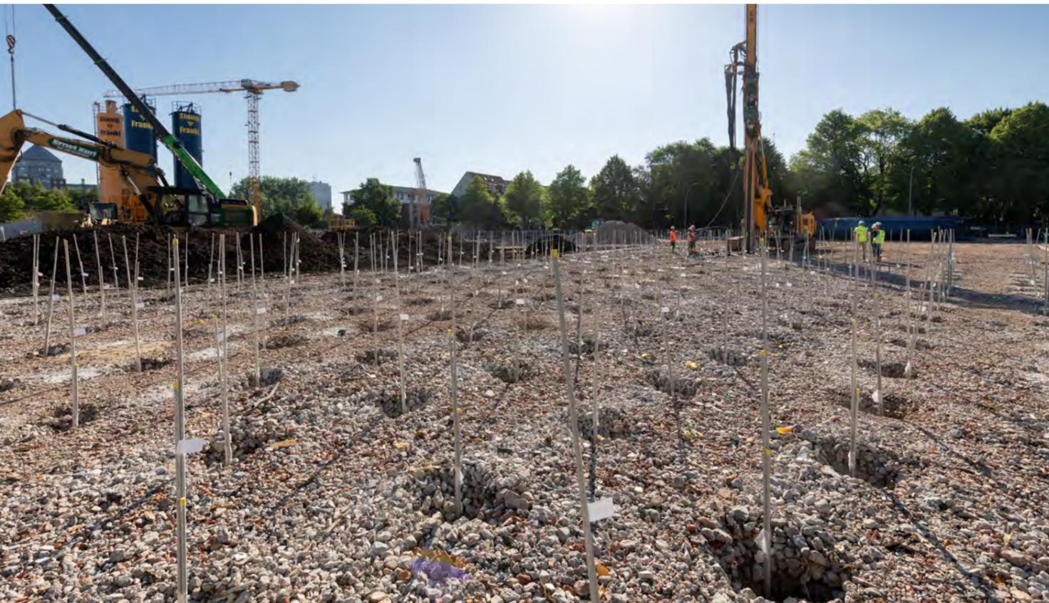
Weichgel-Injektionssohle als Dichtsohle mit geringem CO<sub>2</sub>-Footprint
