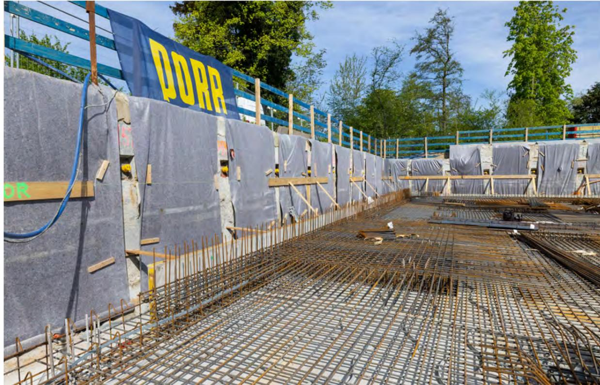
Baugrubenverbau im Einphasen-Schlitzwandverfahren
