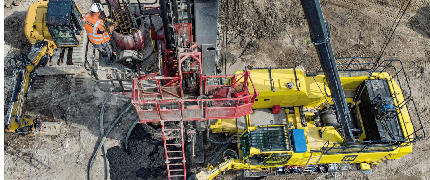
Betonieren eines Teilverdrängungsbohrpfahles
