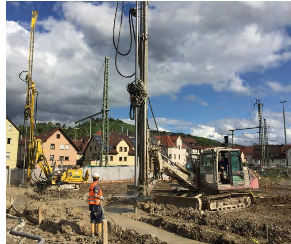
Ausführung der DSV-Abdichtung mit zwei Bohrgeräten
