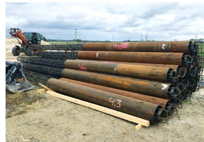
Frankipfähle NG® für Brücke an der BAB 26. Im Bereich der Torfschichten waren Hülsen zur Stützung der Frischbetonsäulen erforderlich.
