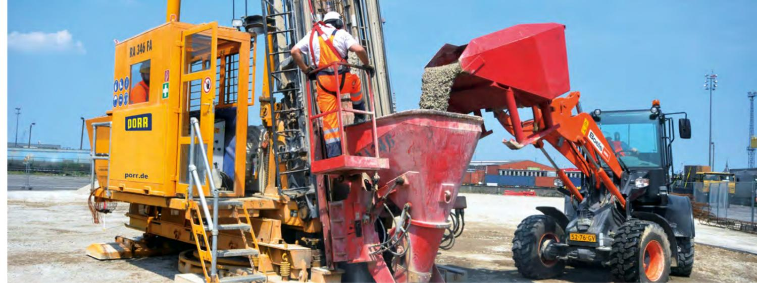
Betonieren eines Frankipfahls NG®
