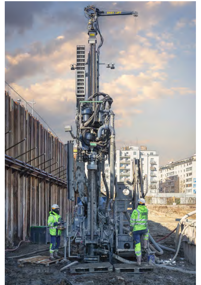
Ausführung der Bohrungen mit eigenen Spezialgeräten und geschultem Fachpersonal
