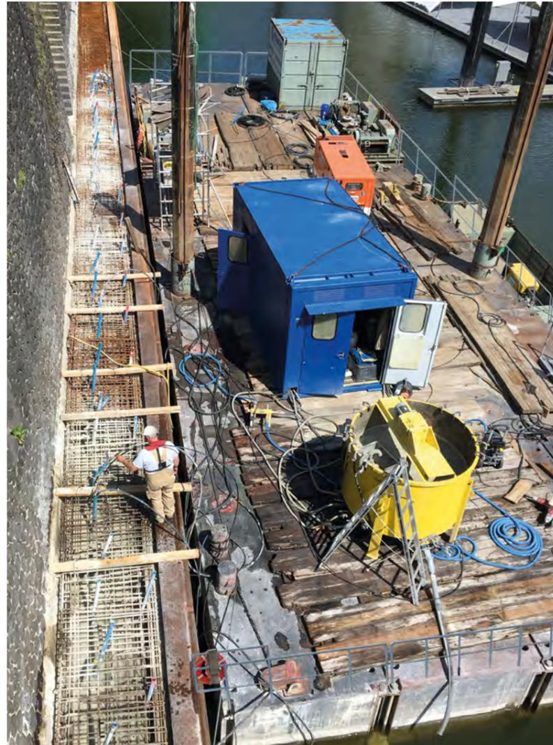
Sanierung einer Uferwand mittels Hohlraumverfüllung
