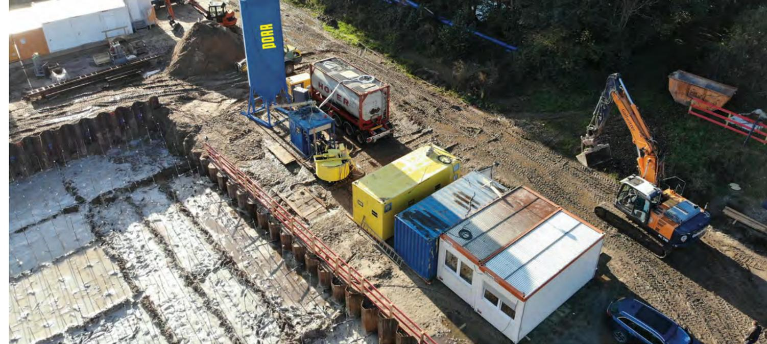
Baustelleneinrichtung für die Herstellung einer Weichgel-Injektionssohle
