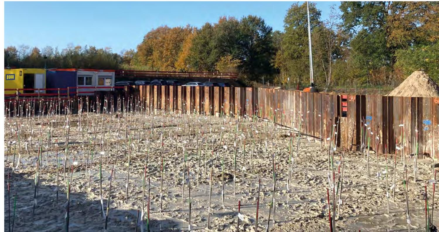
Weichgelinjektionssohle bei einer Baugrube
