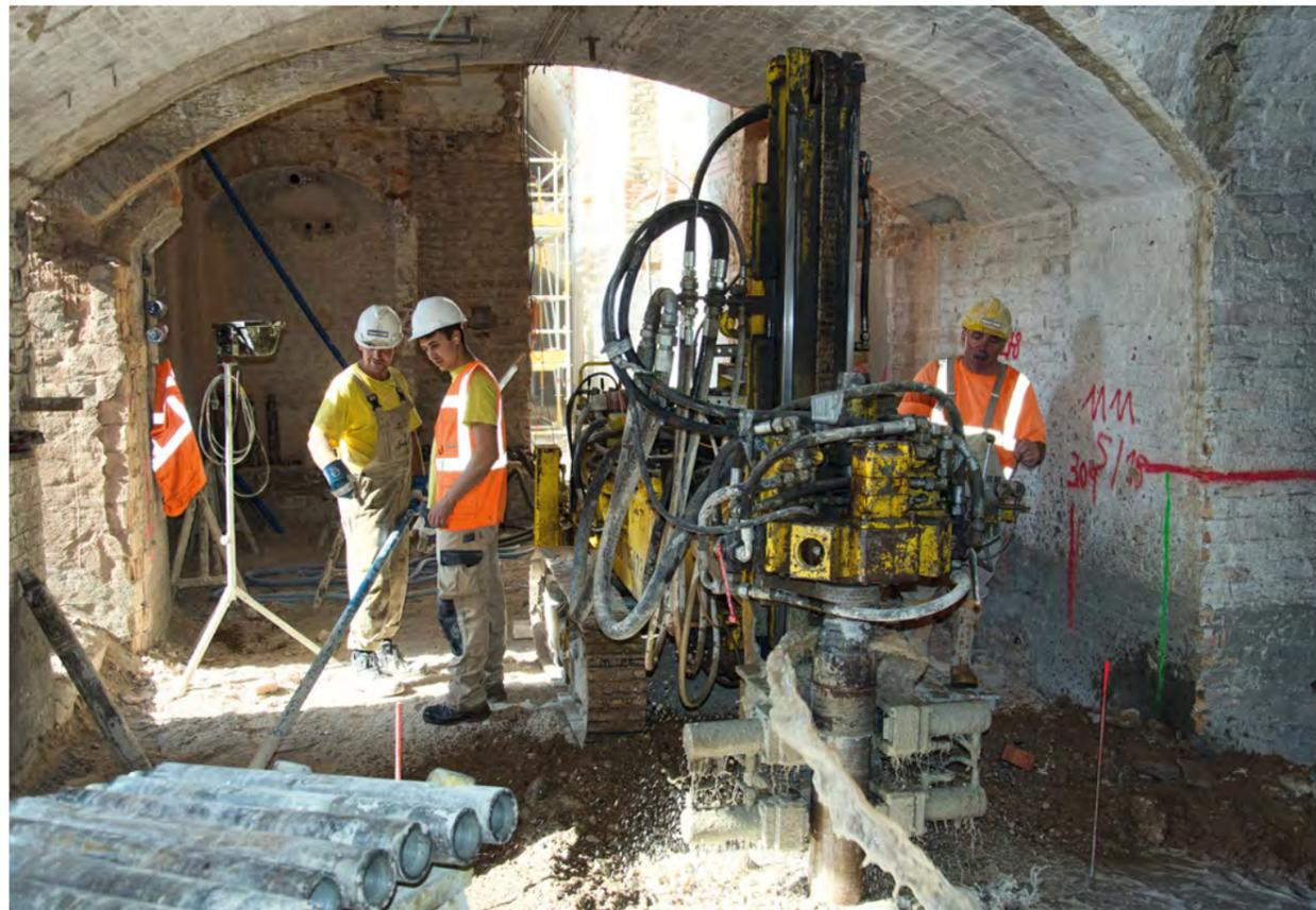
Bohrgerät unter beschränkter Höhe im Einsatz
