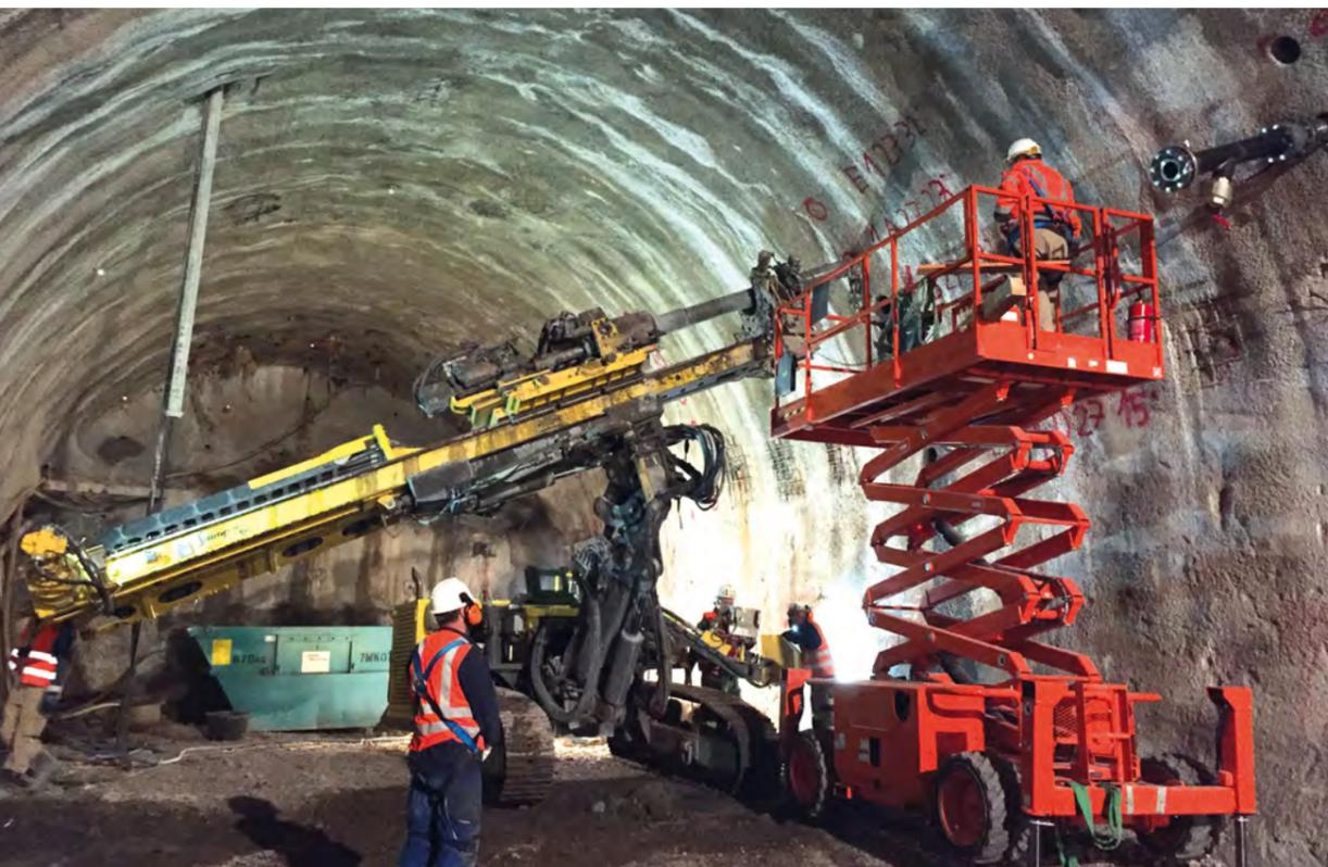
Bohrarbeiten für Packerinjektion mit Zementpasten
