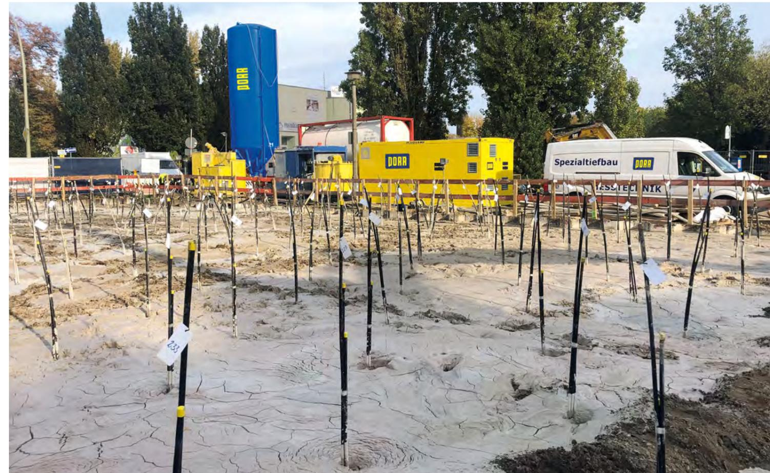
Herstellung einer Dichtsohle mit Weichgel als Injektionsmittel
