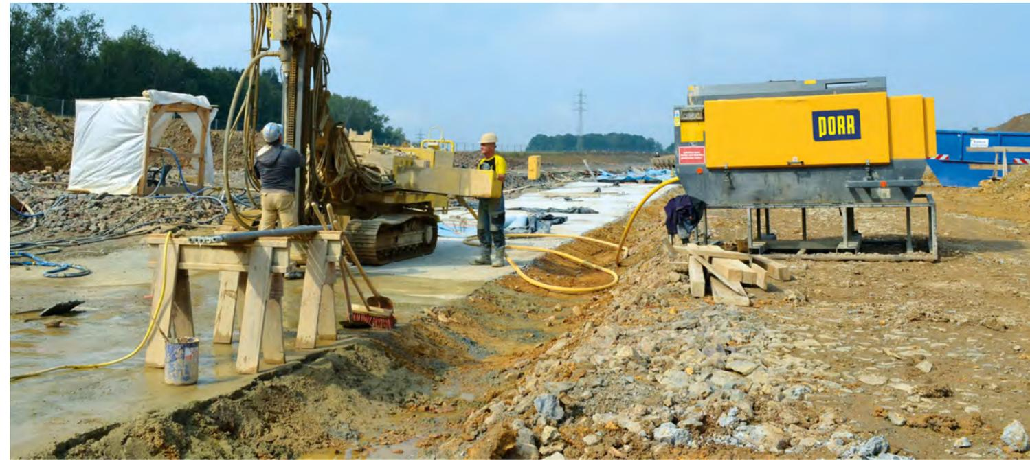
Bohrarbeiten für Kluftinjektion
