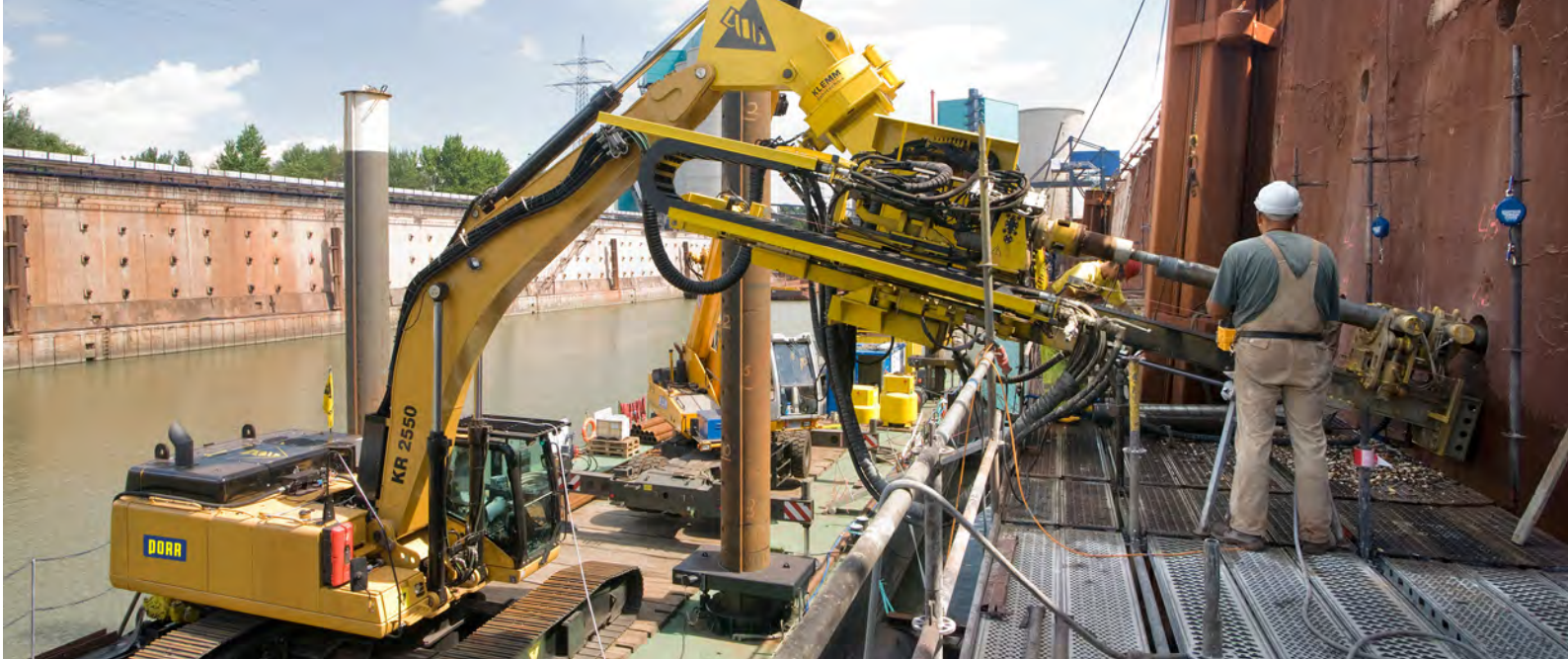
Rückverankerung mit Bohrverpresspfählen, Duisburg Werkschafen HKM
