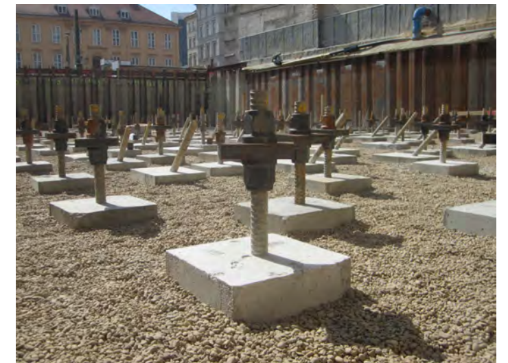
Pfahlköpfe mit Verankerungsplatten
