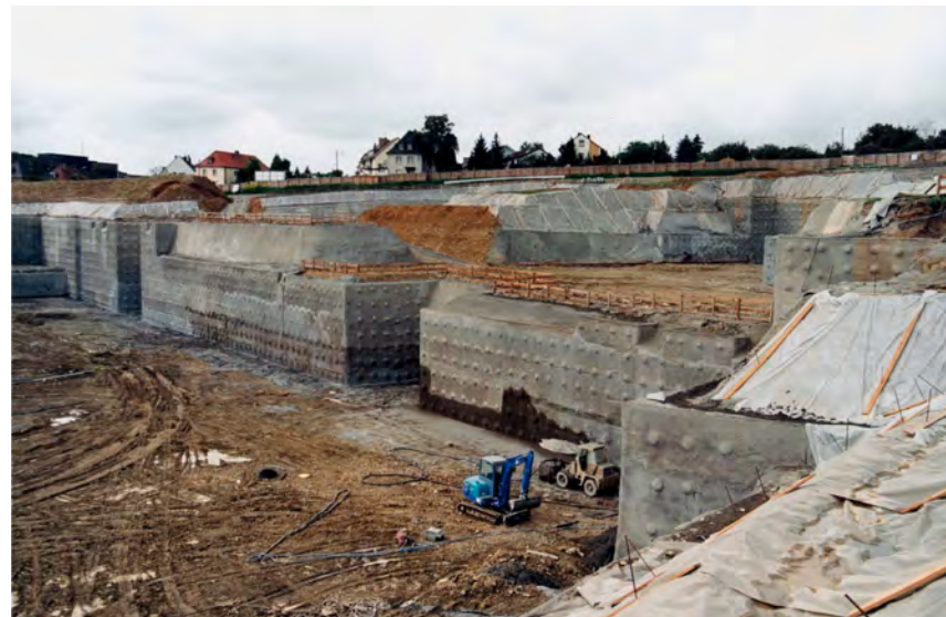
Universitätsklinik, Würzburg, Bodenvernagelung System Stump
