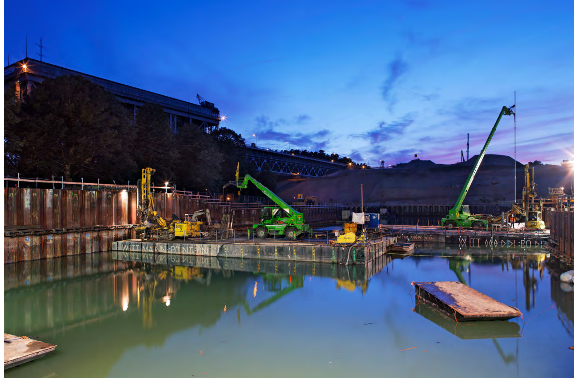
Schiffshebewerk, Niederfinow, Verbundpfahl System Stump
