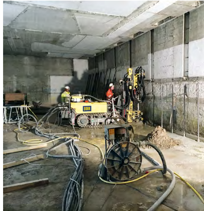
WDR Köln, Verbundpfahl System Stump
