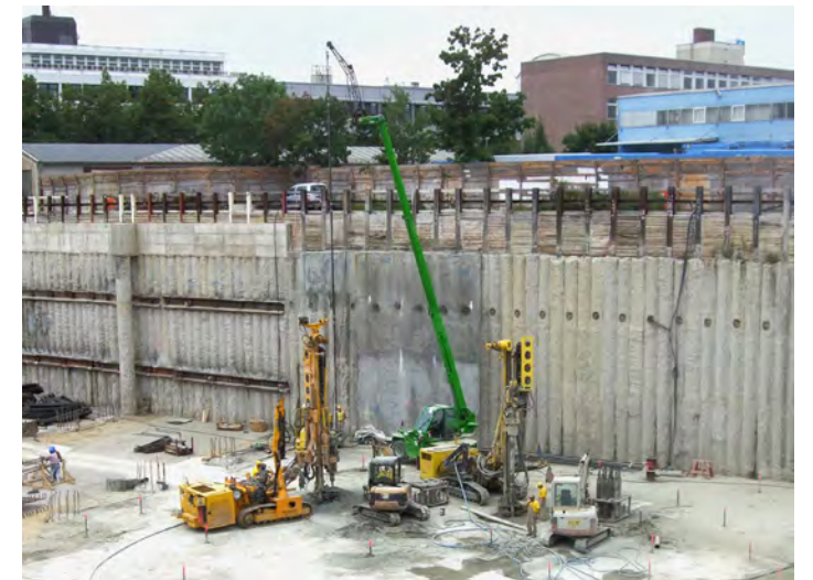
ADAC, München, Verbundpfahl System Stump
