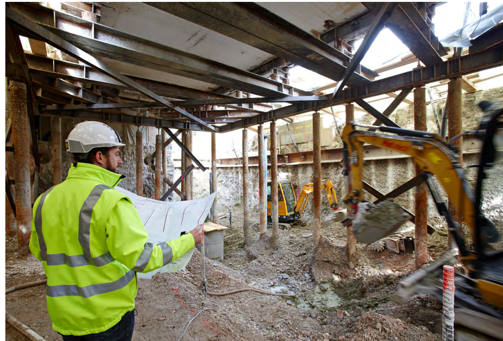
Temporäre Abfangung mit Mikropfählen
