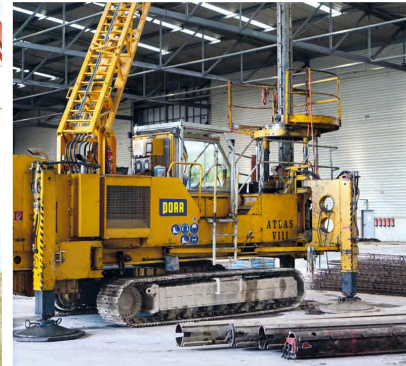
Aufgrund der eingeschränkten Arbeitshöhe werden die Bohrrohre in mehreren Schüssen eingebracht und die Bewehrungskörbe mehrmals gestoßen.
