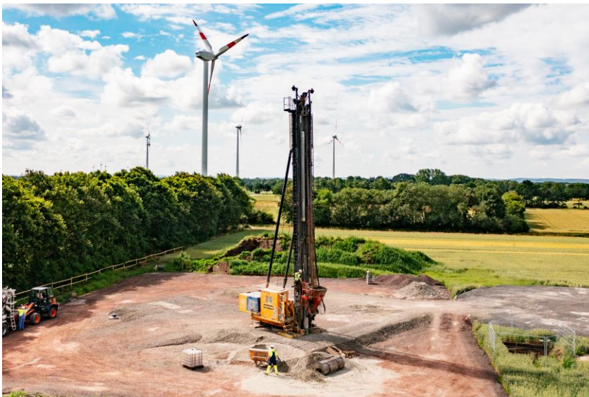
Pfahlgründungen mit schlanken Frankipfählen NG® für den Windpark Stemwede reduzieren CO 2 -Ausstoß. © PORR
