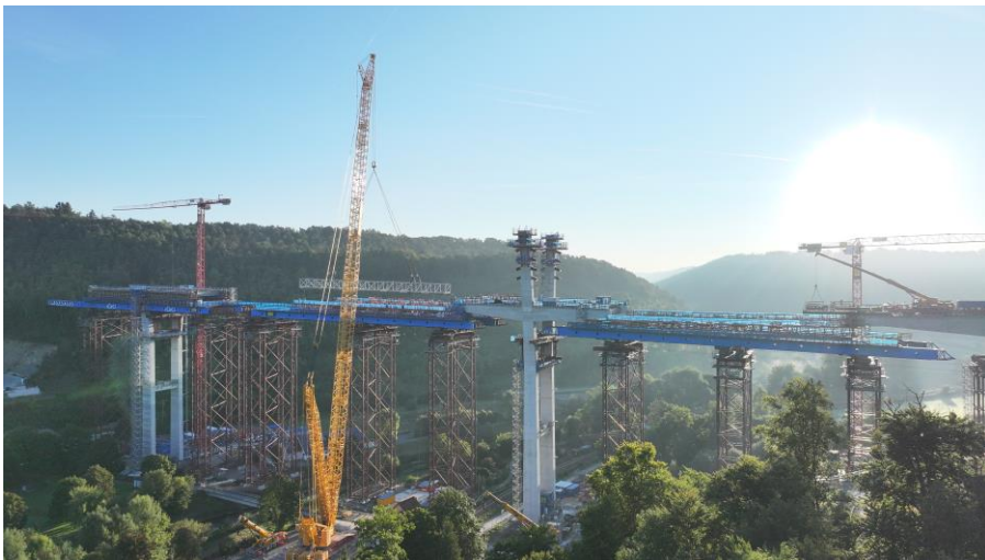
Ein 700-Tonnen-Raupenkrane hebt bis zu 14 cm dicke Grobbleche millimetergenau ein. © PORR
