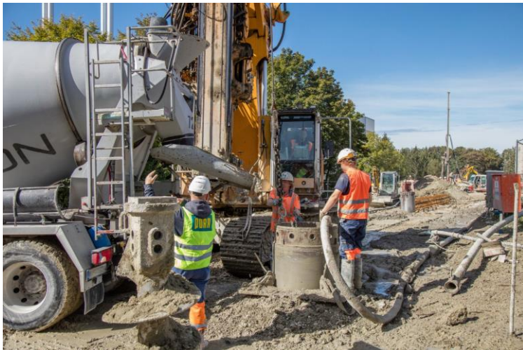
Betonage eines Bohrpfahls im Klärwerk Großlappen. © PORR
