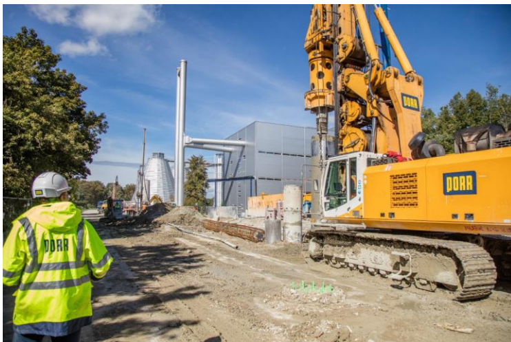
Die Bohrpfähle mit Durchmessern bis 880 Millimeter werden bis 13,5 Meter lang. © PORR
