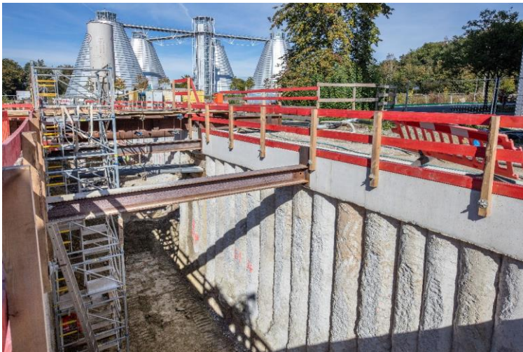
Rund 200 m überschnittene Bohrpfehlwand wurden hergestellt. © PORR
