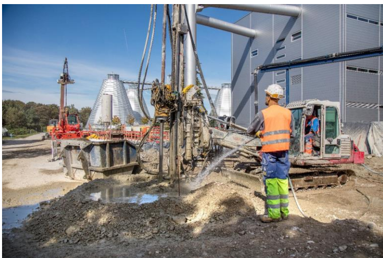
Abdichtungen und Unterfangungen werden im Düsenstrahlverfahren hergestellt. © PORR
