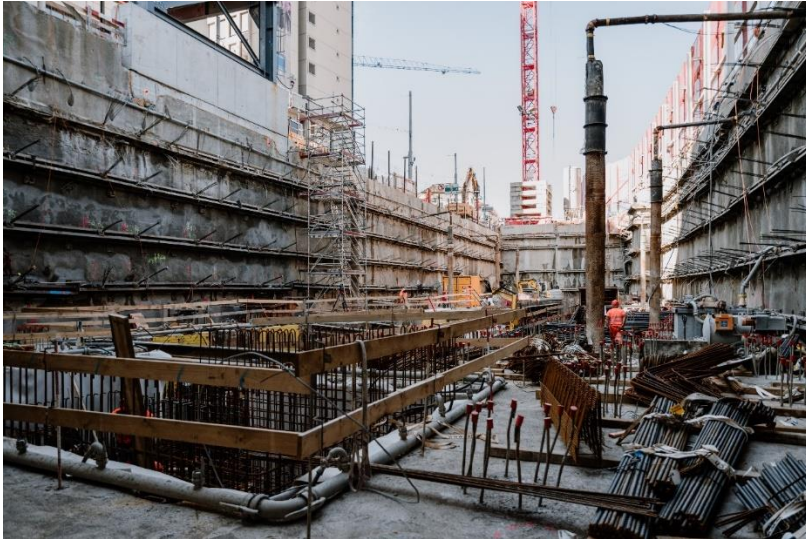
Bildunterschrift: Baugrube des Franklinturms in Zürich-Oerlikon © PORR
